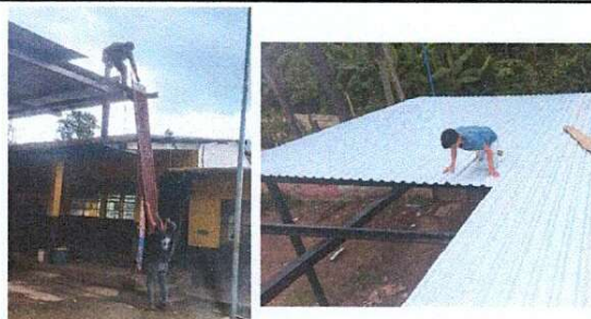
Foto1: CAMBIO DE LAMINAS
