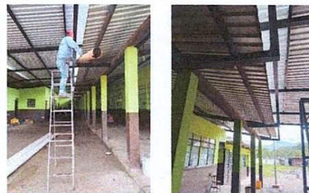
Foto 6: SUSTITUCIÓN DE CANAL PVC
