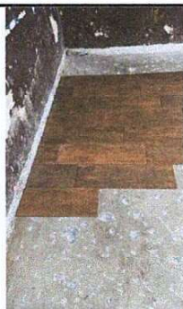
Foto 9: SUSTITUCIÓN DE PISO CERAMICO EN AULAS
