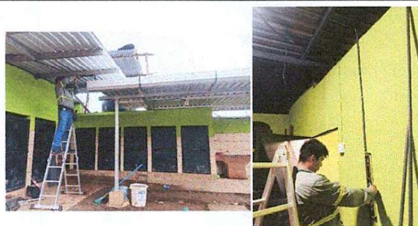
Foto 12: REPARACIÓN DE SISTEMA ELECTRICO
