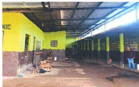
Foto 8: PINTURA DE MUROS INTERIORES
