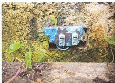
Foto 11: NO SE CAMBIARON LOS FLIPONES TODA VEZ QUE SE ENCONTRO UN CORTO CIRCUITO EN LOS TOMACORRIENTES DEL MURO PERIMETRAL LO QUE DISPARABA LOS FLIPONES.
