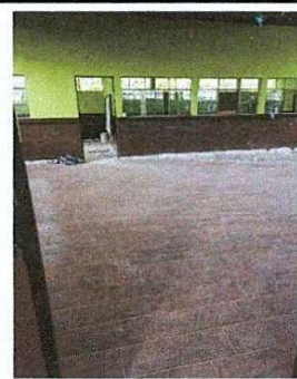
Foto 10: SUSTITUCIÓN DE PISO CERAMICO EN SALÓN
