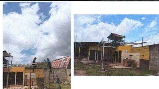
Foto 2: CAMBIO DE ESTRUCTURA DE METAL Y LAMINAS
