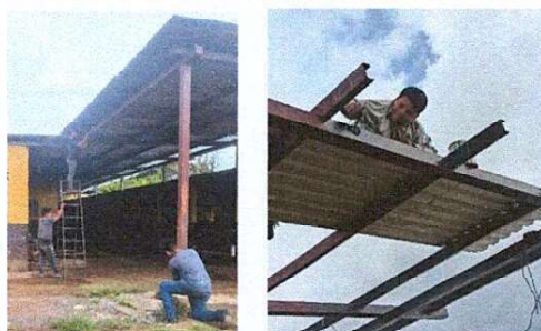
Foto 3: MANTENIMIENTO DE ESTRUCTURA DE METAL
