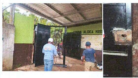
Foto 4: PINTURA DE PORTÓN Y CAMBIO DE CHAPA
