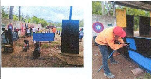
Foto 5: MANTENIMIENTO DE PUERTA DE AULAS
